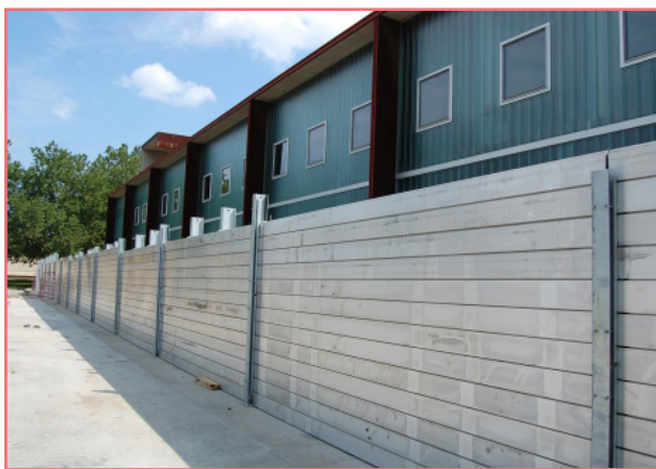
شکل ۲۲- کنترل سیلاب با نصب دیواره‌های موقت در آمریکا
