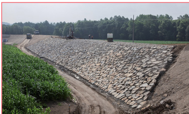
شکل ۳۰- احداث دیواره سیل‌بند برای کنترل سیلاب
