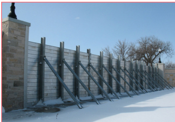
شکل ۲۱- کنترل سیلاب با نصب دیواره‌های موقت در آمریکا
