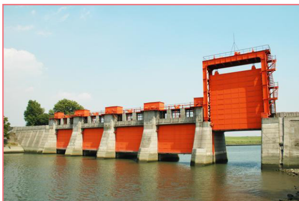
شکل ۱۴- استفاده از دروازه‌های تنظیمی برای کنترل سیلاب در ژاپن
