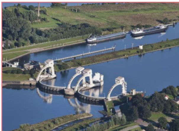
شکل ۱۹- کنترل دبی رودخانه با حوضچه متحرک در هلند
