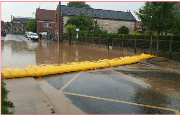
شکل ۲۶- استفاده از آببندهای موقت در نگهداری سیلاب خیابانی در کانادا
