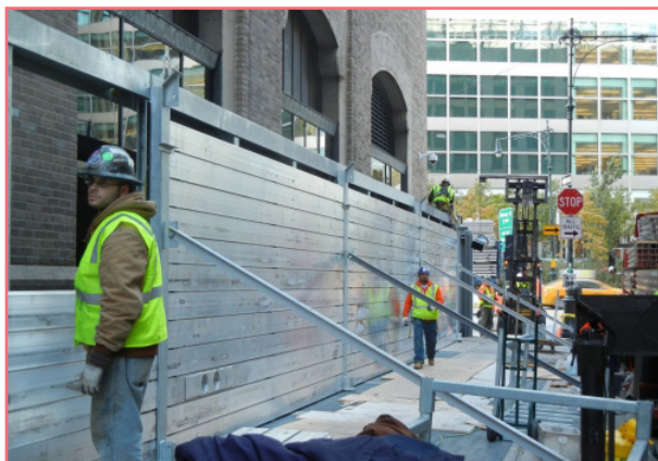
شکل ۲۳- کنترل سیلاب با نصب دیواره‌های موقت در آمریکا
