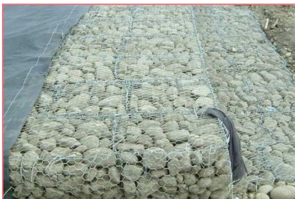
شکل ۲۹- احداث سد خشکه‌چین برای کنترل سیلاب
