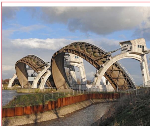
شکل ۱۸- کنترل دبی رودخانه با حوضچه متحرک در هلند
